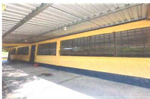
FOTO4: VENTANAS Sustitución de ventanas; sistema de apertura: Corredizas, Perfiles color blanco estandar, Material del marco: PVC Material de la ventana: Vidrio, sellado perimetral.
