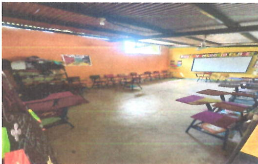
FOTO1: PISO Sustitución de piso de concreto con acabado liso por piso cerámico, incluyendo preparación de superficie y nivelación.
