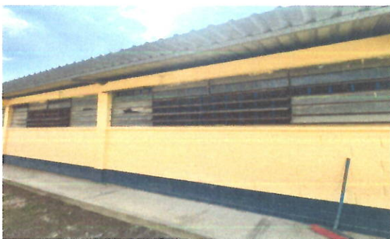
FOTO3: VENTANAS Sustitución de ventanas; sistema de apertura: Corredizas, Perfiles color blanco estandar, Material del marco: PVC Material de la ventana: Vidrio, sellado perimetral.
