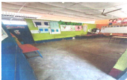
FOTO2: PISO Sustitución de piso de concreto con acabado liso por piso cerámico, incluyendo preparación de superficie y nivelación.
